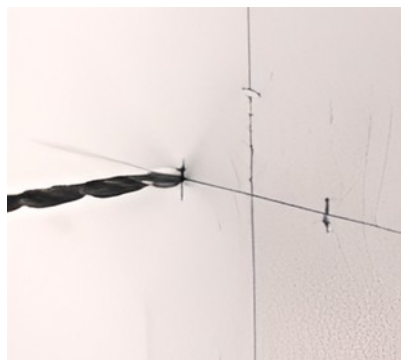
Схема высверливания гнезд
