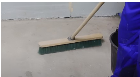
Очистка основания при помощи щетки
