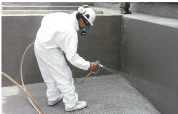
Нанесение гидроизоляции
