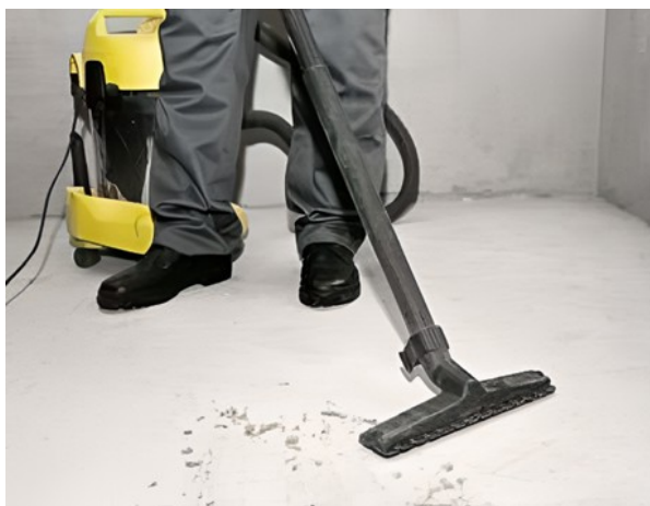
Очистка основания при помощи пылесоса
