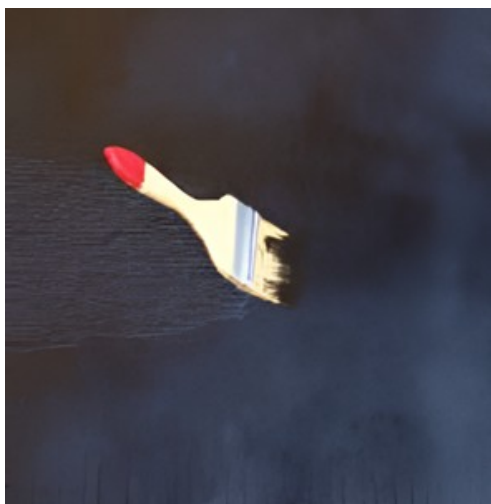
Нанесение второго слоя мастики
