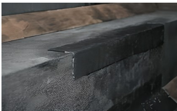
Пример возможного устройства слоя усиления
