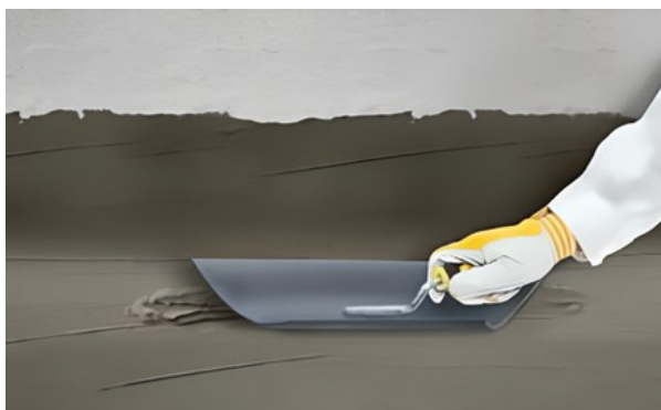
Пример возможного выполнения галтели
