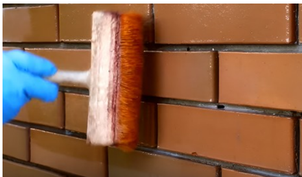
Нанесение гидрофобизатора
