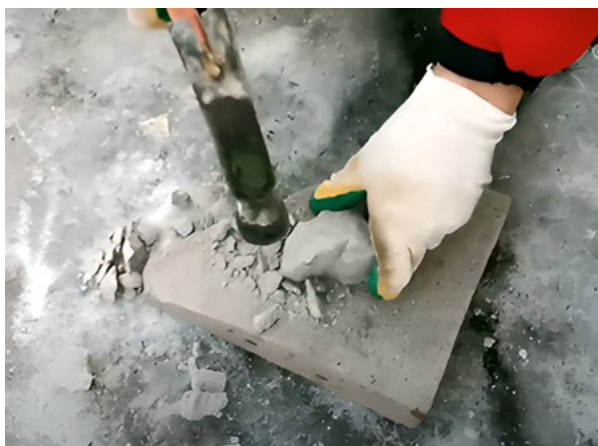
Раскалывание газоблока на мелкие части
