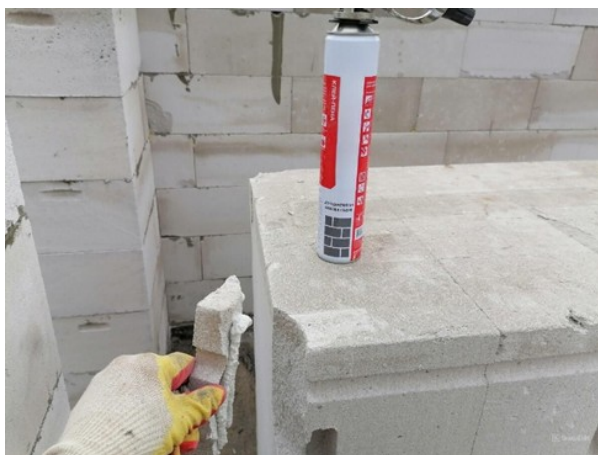
Приклеивание осколка на клей-пену
