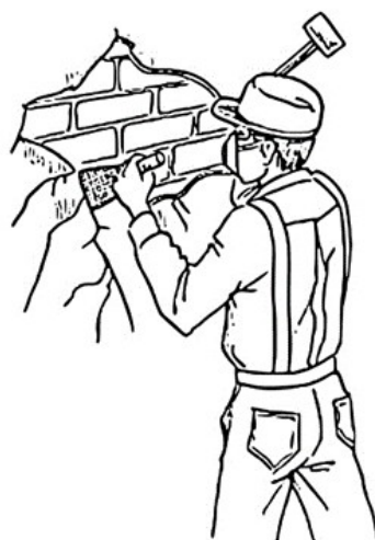
Схема демонтажа штукатурки при помощи шпателя (Схема показана условно)
