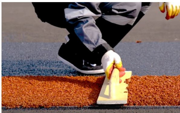
Разравнивание покрытия полиуретановыми терками
