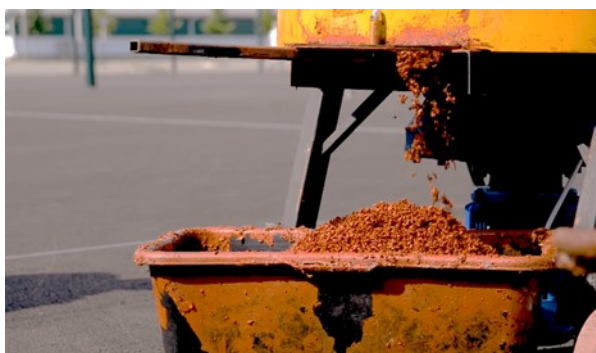
Подготовка смеси для устройства покрытия
