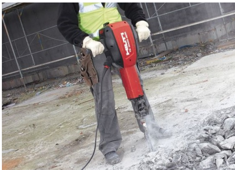
Демонтаж цементно-бетонного покрытия
