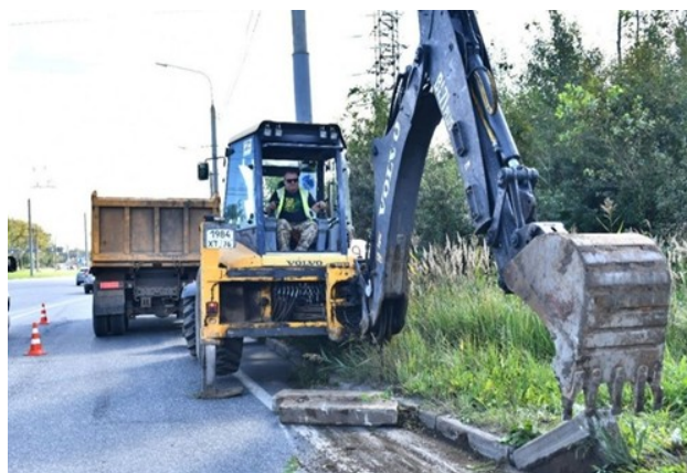
Разборка бортовых камней с помощью экскаватора
