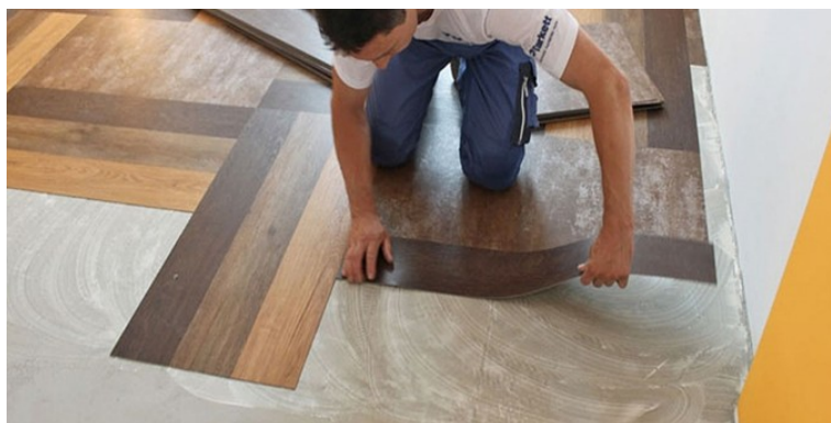
Укладка кварцвиниловой плитки
