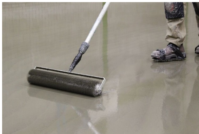
Устройство наливного пола
