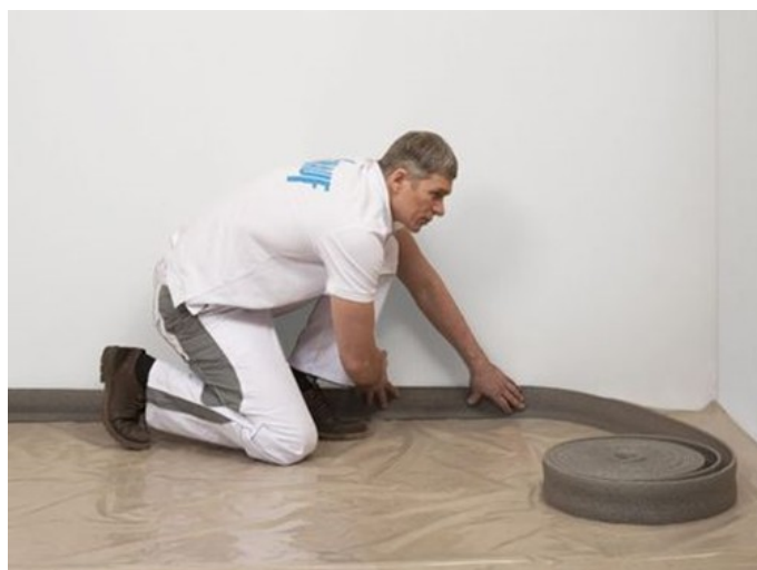
Установка кромочной ленты
