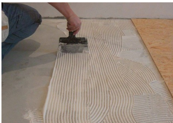
Нанесение клея зубчатым шпателем
