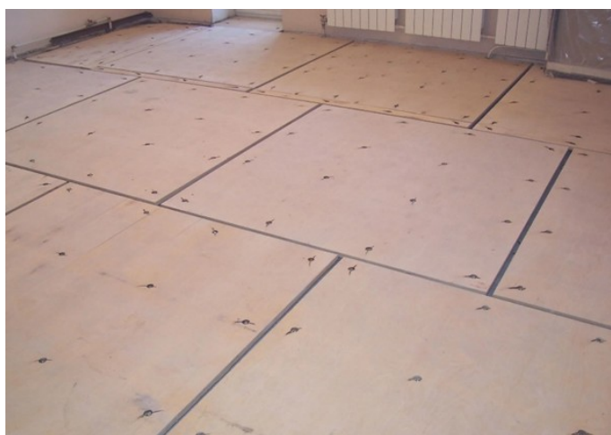
Раскладка и крепление фанеры
