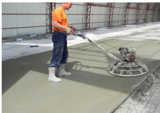
Выглаживание бетонной поверхности
