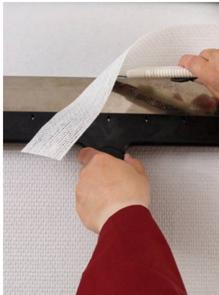
Подрезка обоев
