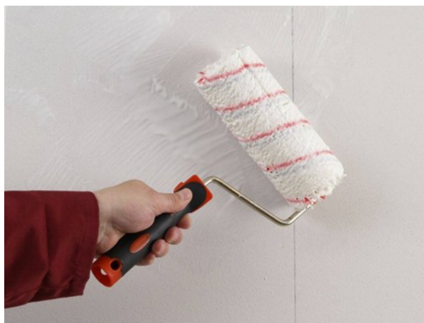
Нанесение клея
