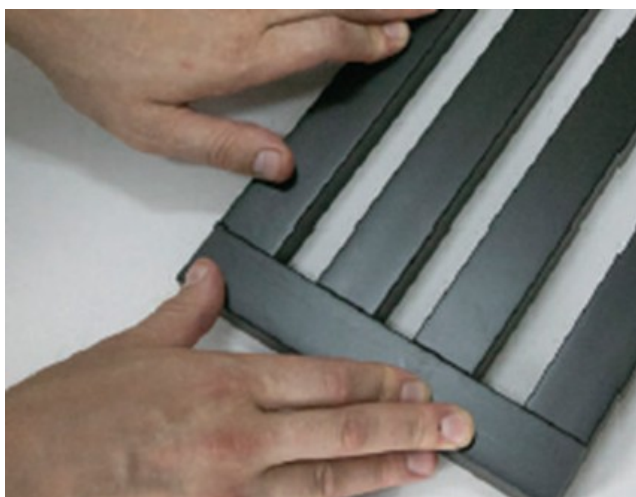
Соединение молдингов на клею
