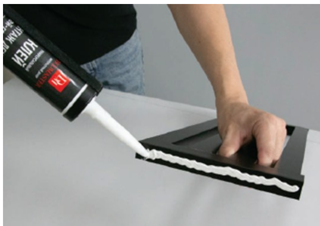
Нанесение монтажного клея
