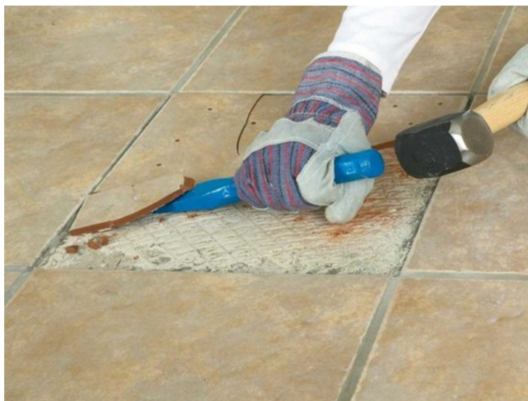
Удаление первой плитки с использованием молотка и зубила
