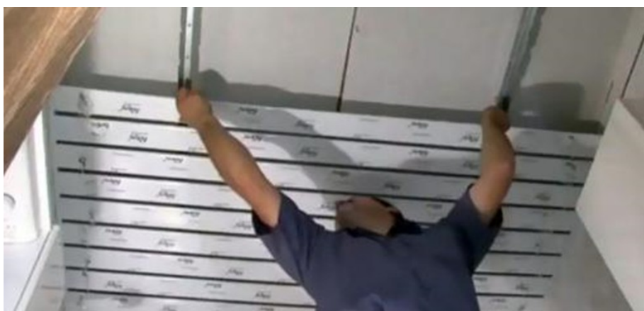
Демонтаж потолка из ПВХ панелей
