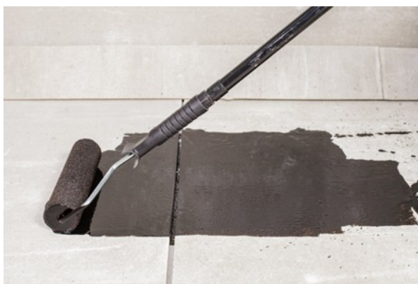
Нанесение праймера с помощью валика
