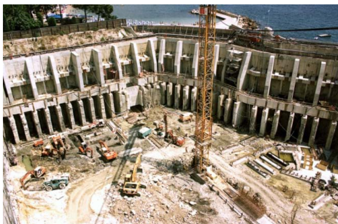
Рис. 22. Устройство ограждающих конструкций котлованов с контрфорсами.
