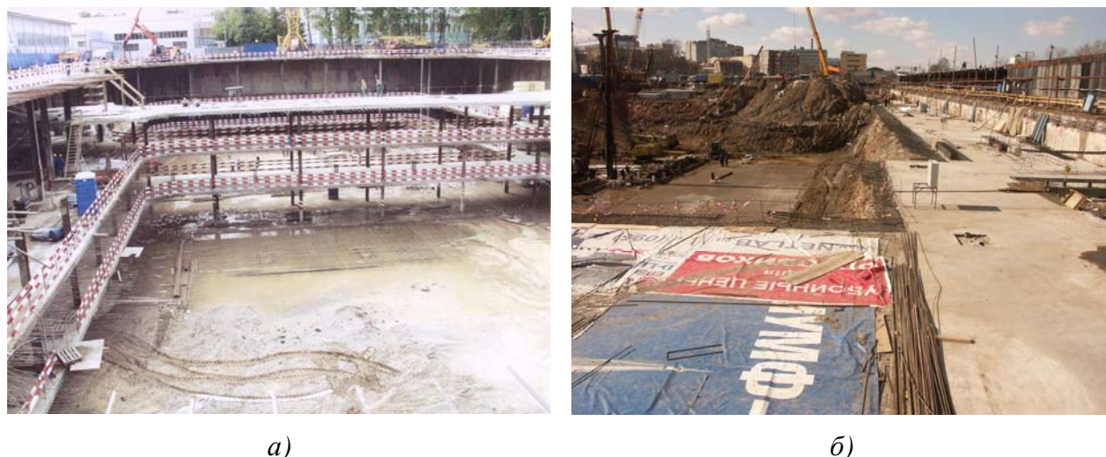
Рис. 20. Комбинированный способ строительства «semy-top-down».
