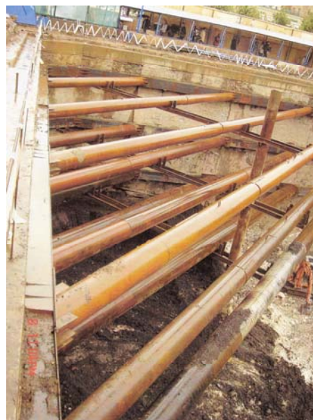
Рис. 14. Многоярусное распорное крепление котлована.
