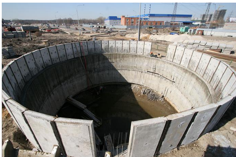
Рис. 3. Погружение сборно-монолитного опускного колодца.
