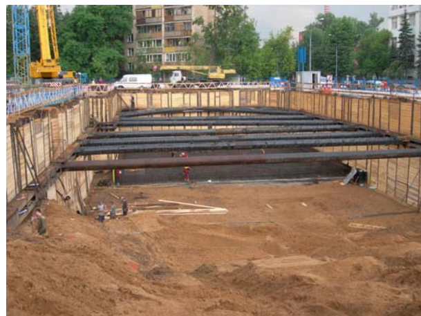
Рис. 4. Ограждение котлована из стальных элементов с забиркой.
