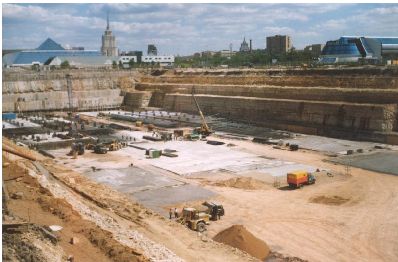
Рис. 1. Котлован Центрального ядра Международного центра «Москва-Сити» (1999)
