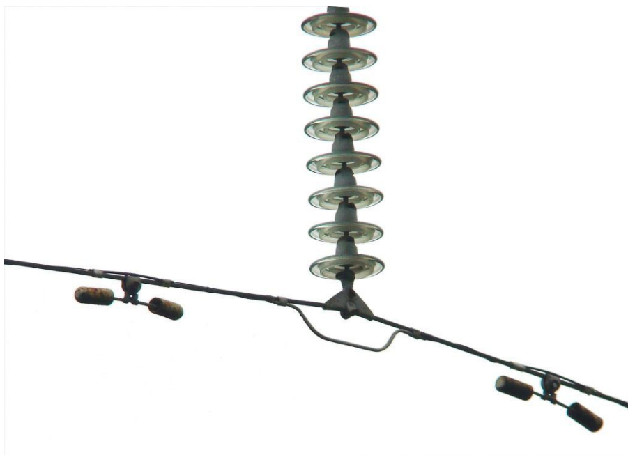
Рисунок 4.16.6 Обвод ОКНН поддерживающего изолятора ВЛ 110 кВ
