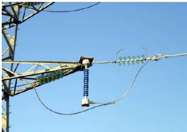
Рисунок 4.14.5 Установка подвесной концевой муфты ОКФП [25]
