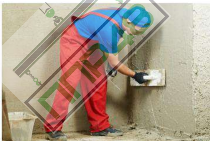
Рис. 13. Оштукатуривание стен
