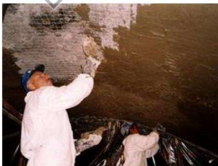
Рис. 18 Заделка мест инъектирования составом Каматрон-эконом
