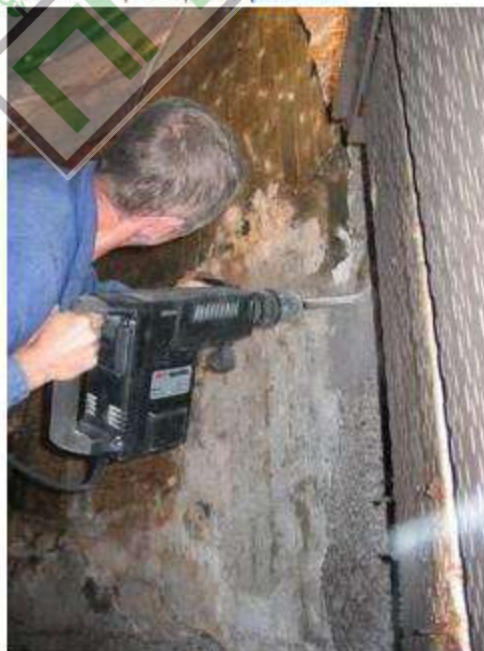
Рис. 16 Бурение шпуров в конструкции фундамента.
