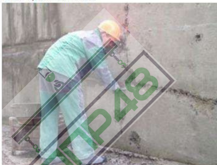
Рис. 18 Заделка мест инъектирования составом Каматрон-эконом
