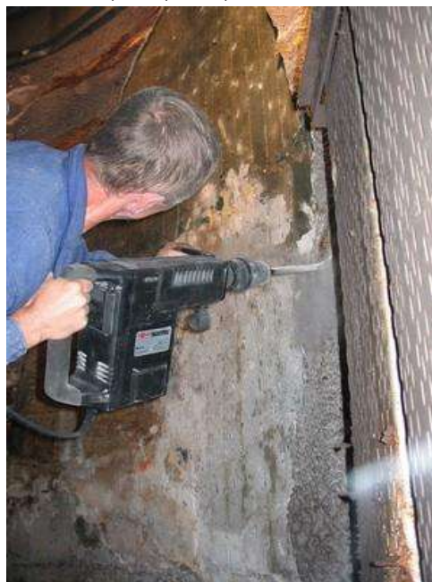
Рис. 16 Бурение шпуров в конструкции фундамента.
