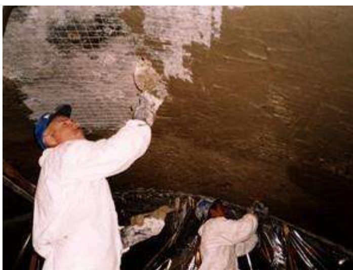
Рис. 18 Заделка мест инъектирования составом Каматрон-эконом
