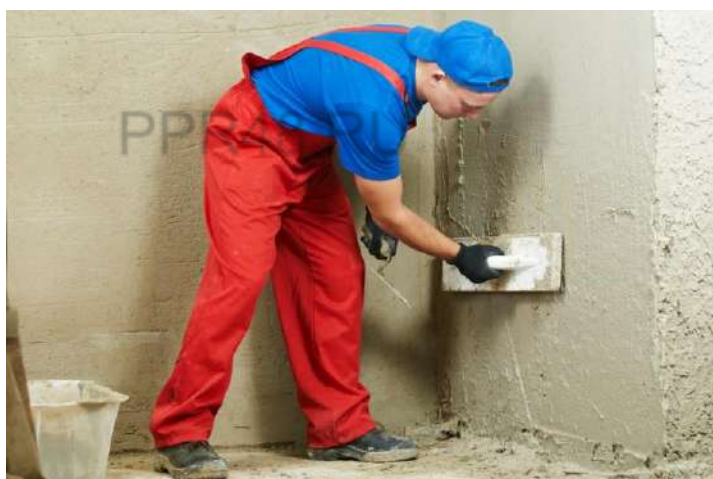
Рис. 13. Оштукатуривание стен
